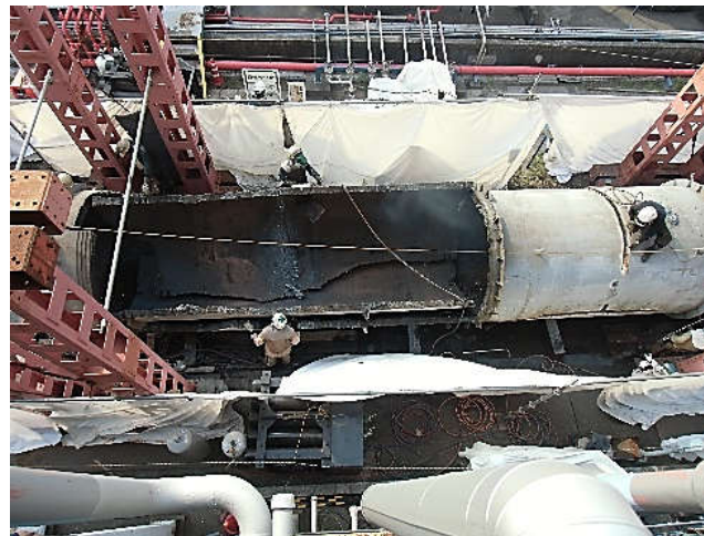
② 旧反応塔解体作業
