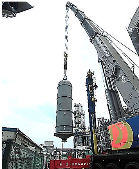
⑧ 吊り上げ・設置作業
