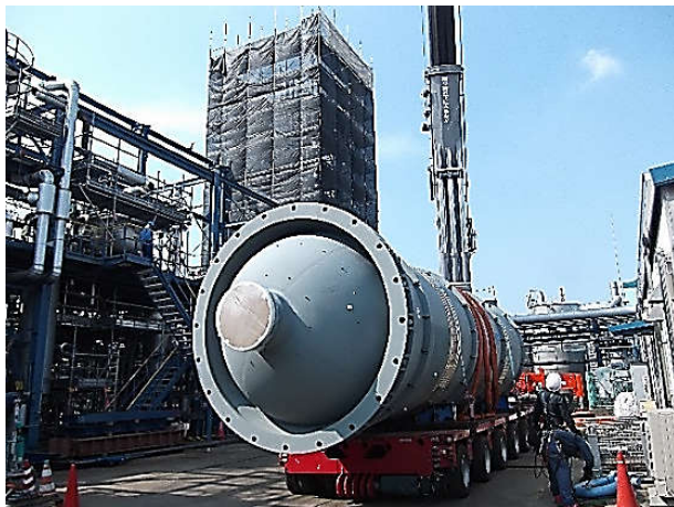
⑦ 搬入完了
