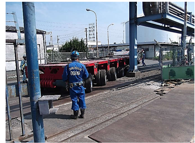
③ 搬入門拡幅工事
