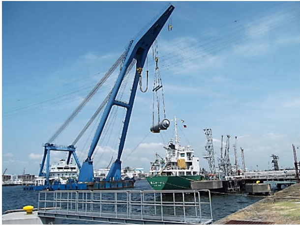
④ 荷揚作業
