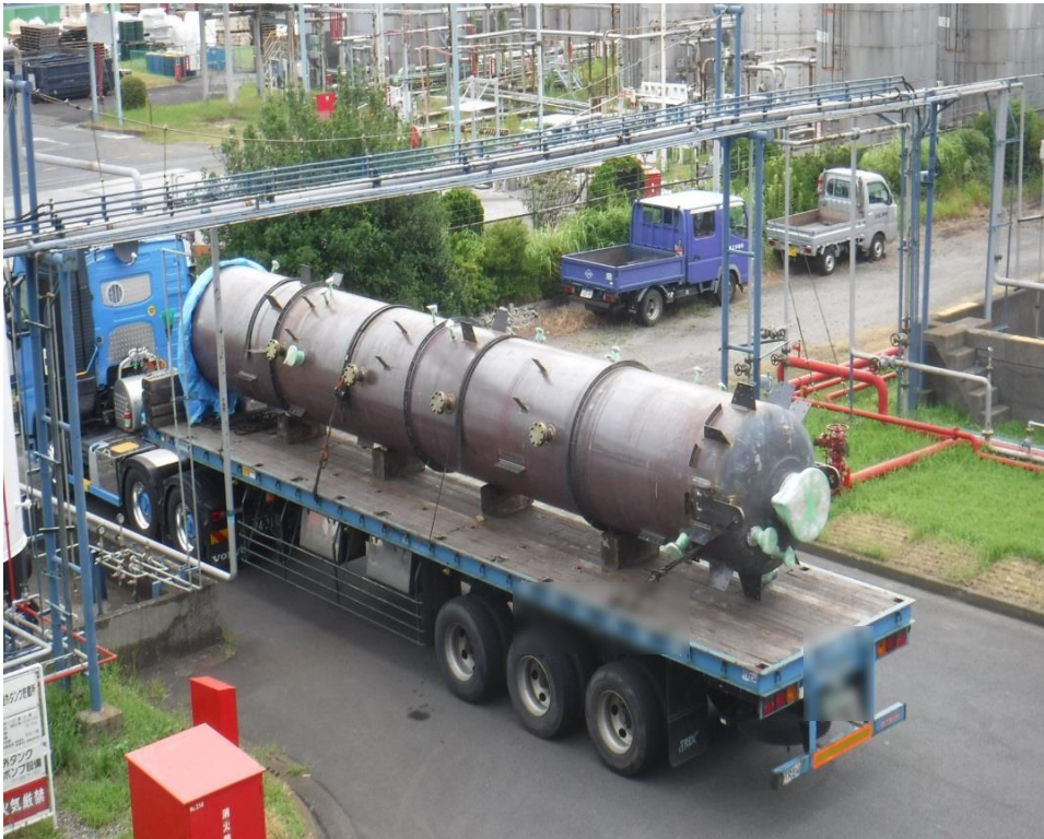
蒸留塔点検補修工事
