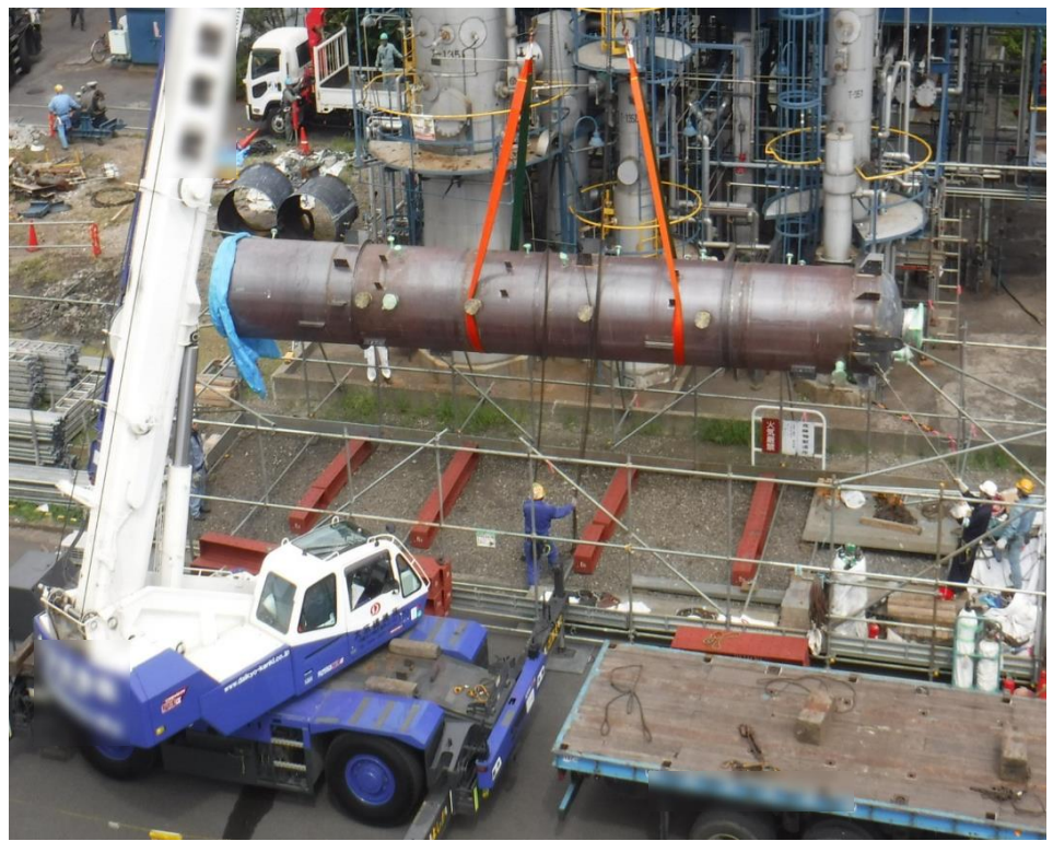
蒸留塔点検補修工事
