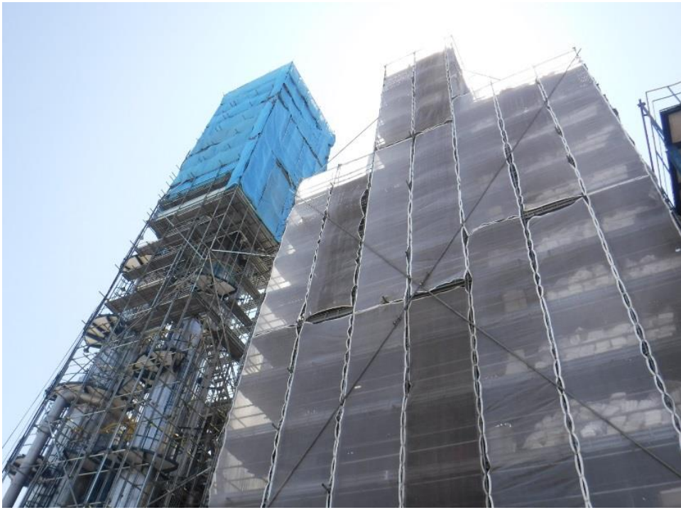
蒸留塔点検補修工事
