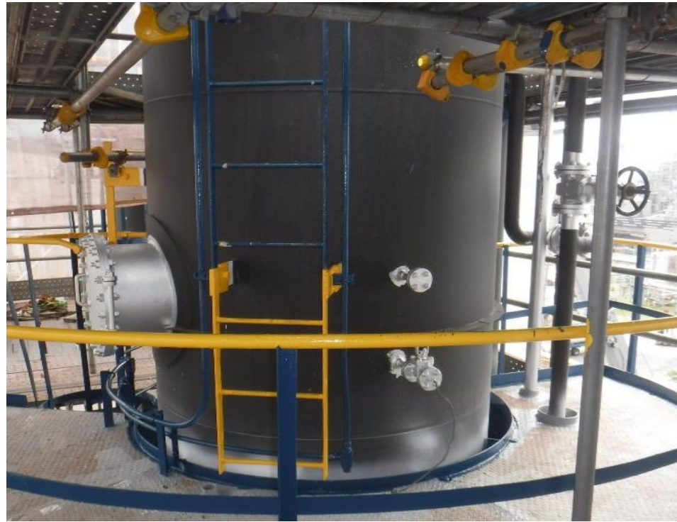
② 含水系蒸留塔(保温前) 1塔
