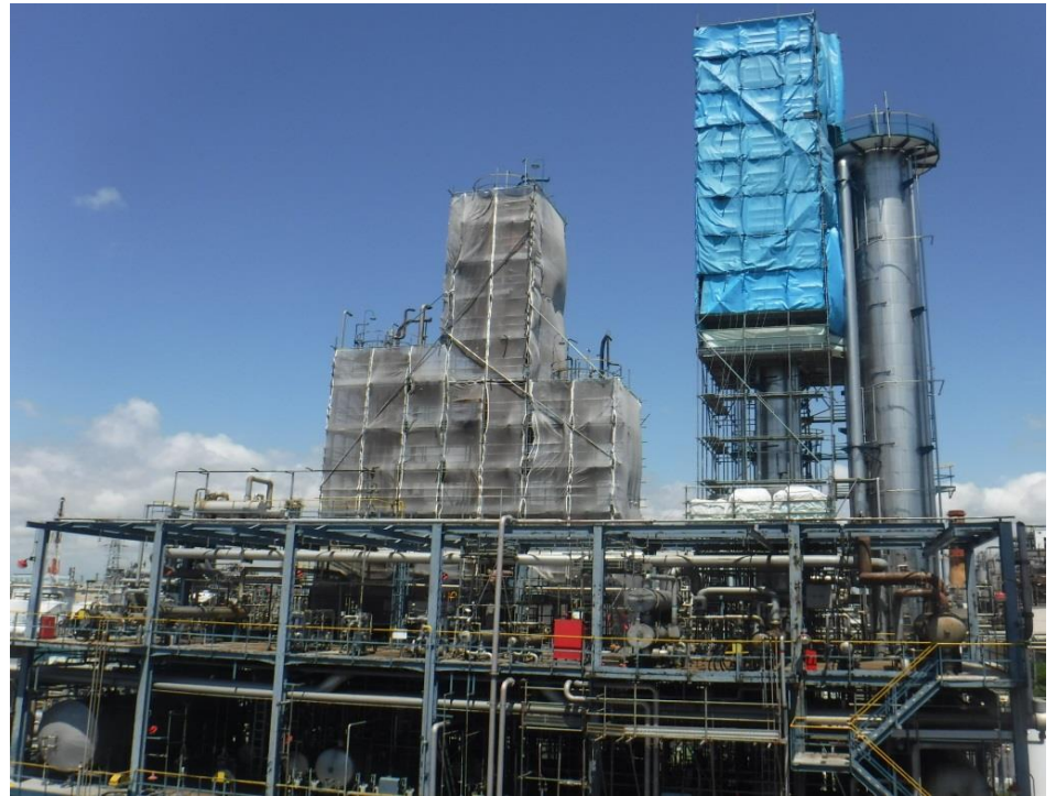
蒸留塔点検補修工事
